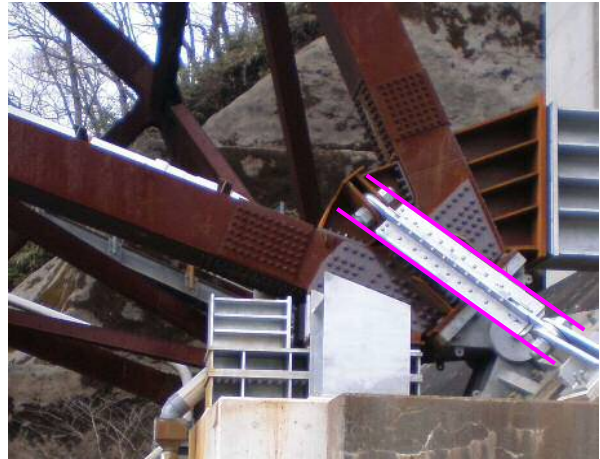
上路アーチ橋支点部【新規に設置】
