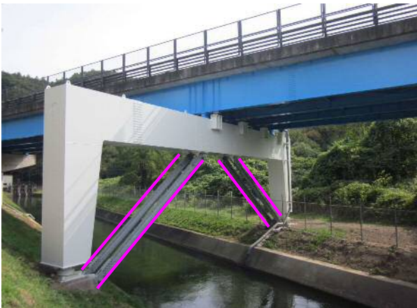
門型鋼製橋脚【新規に設置】
