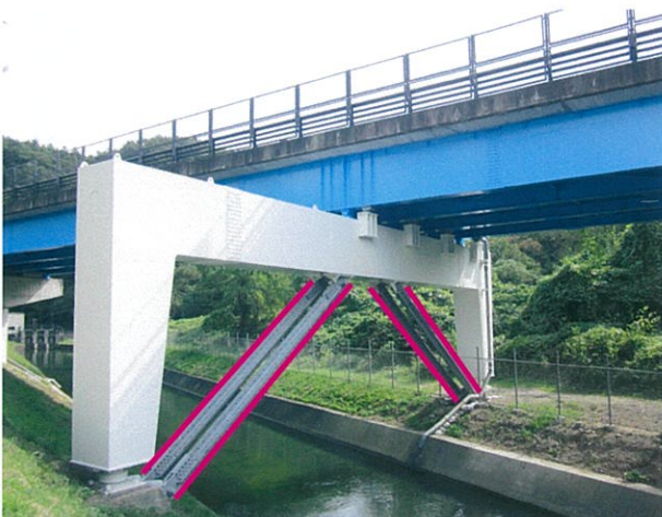
門型鋼製橋脚【新規に設置】
