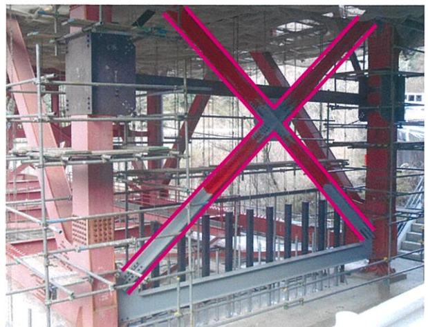
トラス橋【既設置換え】
