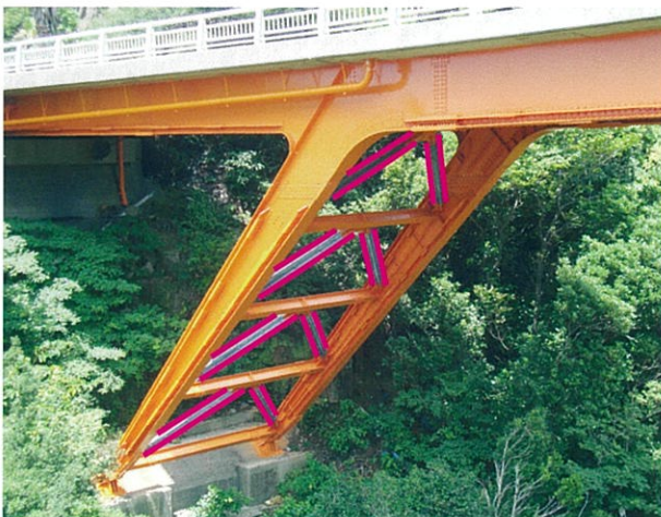
方杖ラーメン橋【既設置換え】
