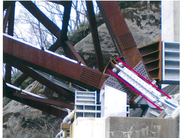
アーチ橋支点部【新規に設置】
