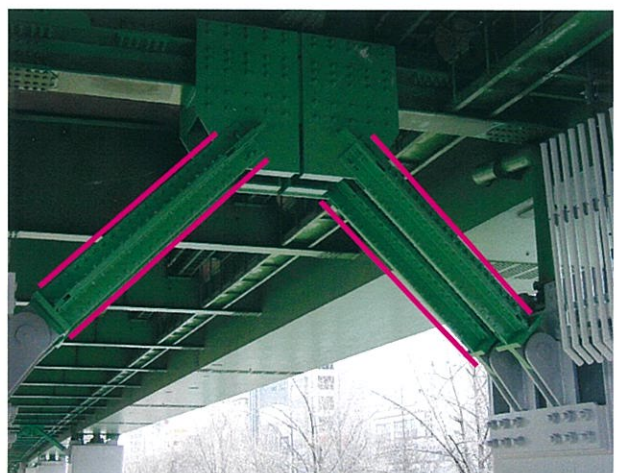
桁橋支点部【新規に設置】
